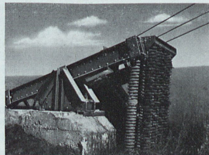
1. ábra Függőpálya tartókötelének lehorgonyzása
