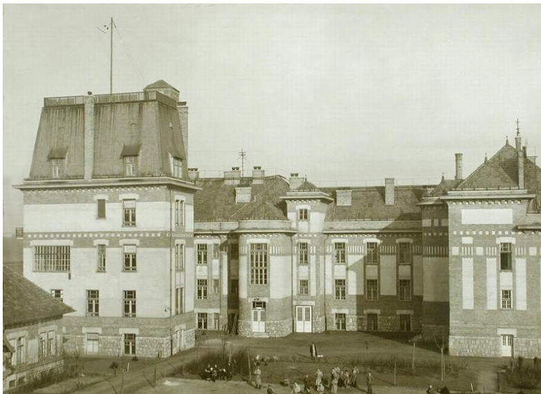
8. 2. ábra, Posta Kísérleti Intézet épülete
