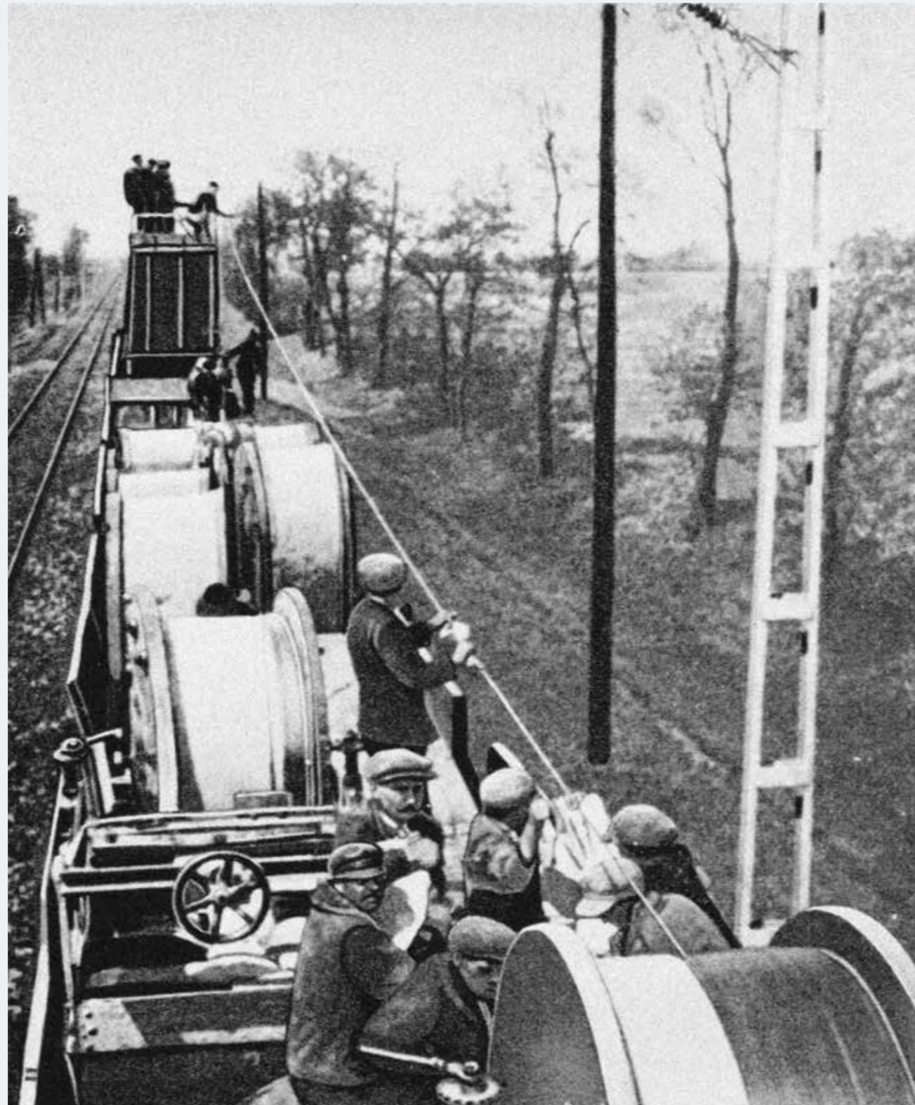
Munkavezeték feszítés a Budapest és Hegyeshalom közötti vasútvonal villamosításán, 1931. A felsővezetékét a Siemens–Schuckert Művek Szár–Tata-Tóváros állomások között telepítették
