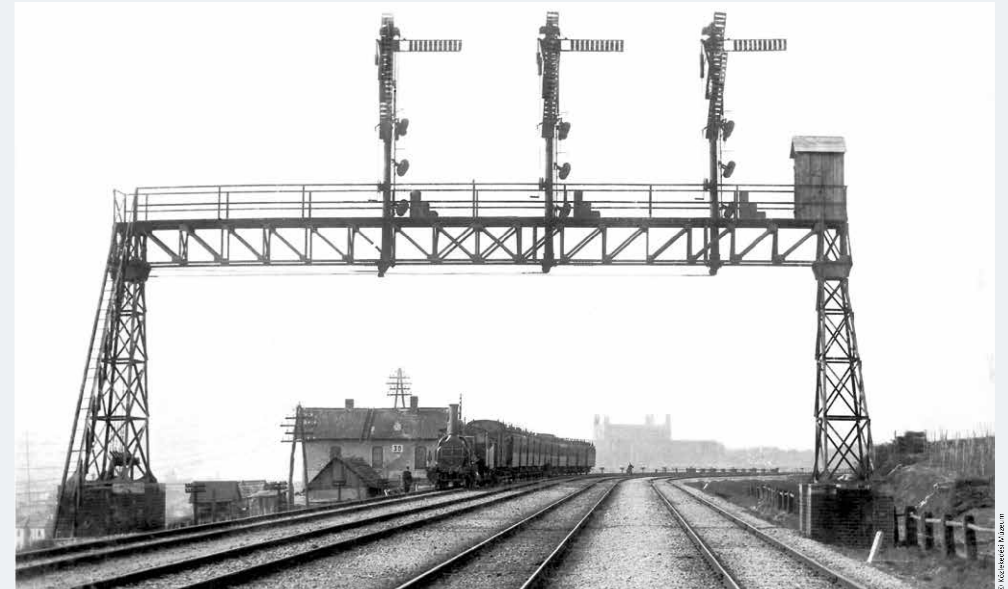
Siemens–Halske típusú kétkarú bejárati jelzők Pozsony határában
