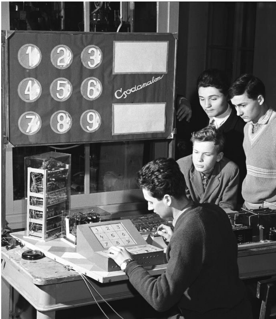
1962: A Mikszáth téri gimnázium kibernetikai szakkörének egyik büszkesége a csodamalom, amely a malomjátékot játssza élő ellenféllel. A 40 jelfogóval működő asztali készülék ugyanannyit tud, mint a Philips gyár 136 elektroncsóvel és ugyanannyi germánium dióddal működő szobanagyságú berendezése. Vesztergombi György, a gép egyik építője ellenőrzi a játék működését. (MTI Fotó: Mikó László)
