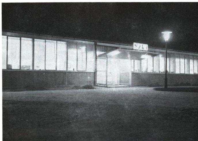
Az SzKI első önálló épülete az EMG területén felállított barakk, 1970
