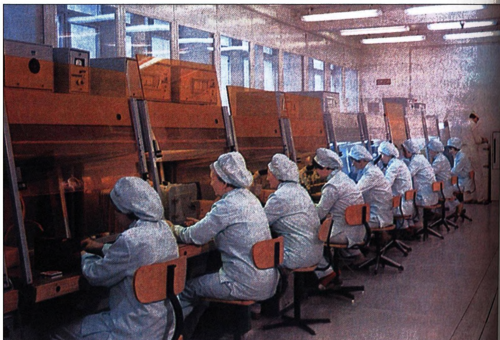
16.3. ábra. Fotolitográfia (un. Tantál sor) vékonyréteg ellenállásokhoz és kondenzátorokhoz. (HIKI 1974)
