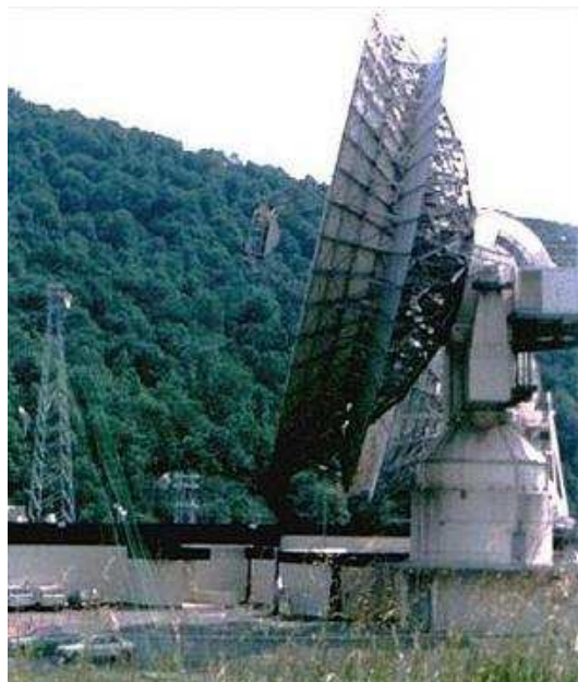
Műholdas földi terminál Etam-nál (West Virginia), amelyik az Intelsat IV-en keresztül köti össze Európát az USA-val
