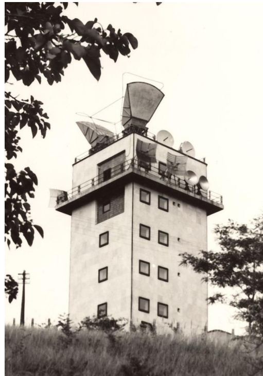
Az utólag felépített gödöllői átjátszó állomás a keleti láncon, melynek megépítése azért vált szükségessé, mert a túl nagy Széchenyi hegy–Kékestető távolság okán, a változó terjedési viszonyok (fading) miatt az összeköttetés gyakran megszakadhatott volna. (Fotó: a Postamúzeum gyűjteményéből)
