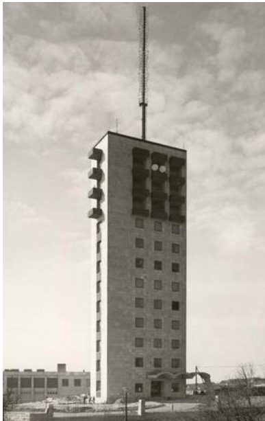
Az 1958-ban felépített Széchenyi hegyi TV adótorony. Ennek legfelső emeletén helyezték el a keleti lánc, GTT 4000/A típusú végállomását.
