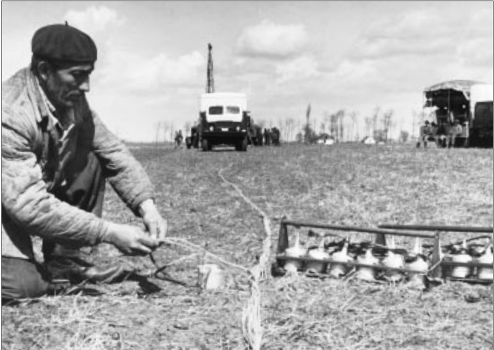
19 Szabó László kiváló dolgozó a magyar gyártmányú Ács–Stegena-féle geofonokkal és a kábellel, háttérben a fúróberendezésekkel, műszer- és kábeleskocsival (1962)
