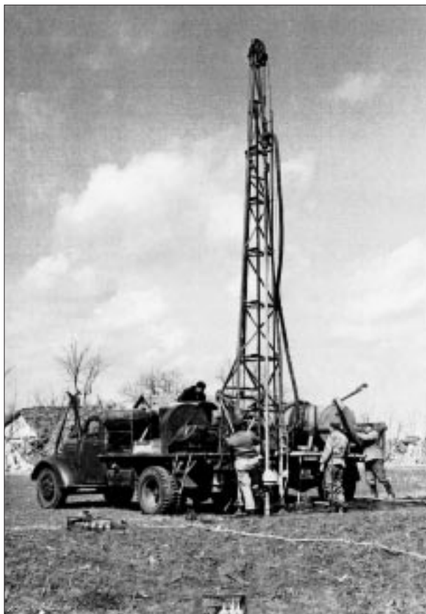
Szeizmikus robbantópont fúrása SzBU berendezéssel (kb. 1960)
