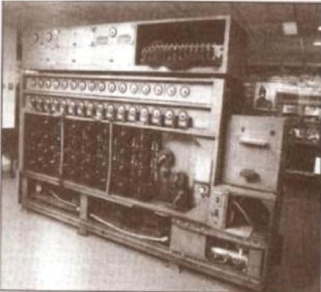
BOMBA (angol). Az ENIGMÁVAL rejtjelezett üzenetek megfejtésére, elektromechanikus. A. Turing dolgozta ki.
